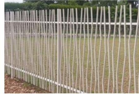
Barreaux façon brisures interpénétrants sur la face extérieure des lisses de manière aléatoire.
