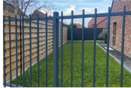
Barreaux ronds interpénétrants dans les lisses sur le côté extérieur.
