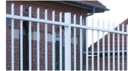
Barreaux losanges centrés dans les lisses.
