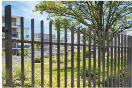
Barreaux rectangulaires interpénétrants dans les lisses sur le côté extérieur.
