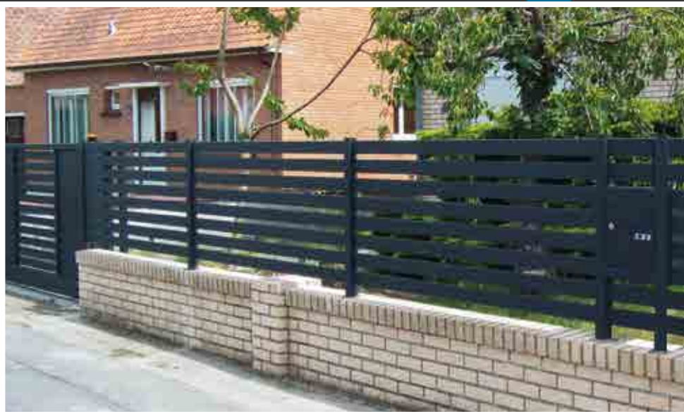
Ensemble lames horizontales espacées sur muret
