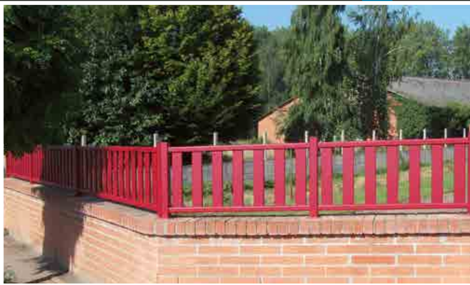
Clôture alu avec lames verticales sur muret
