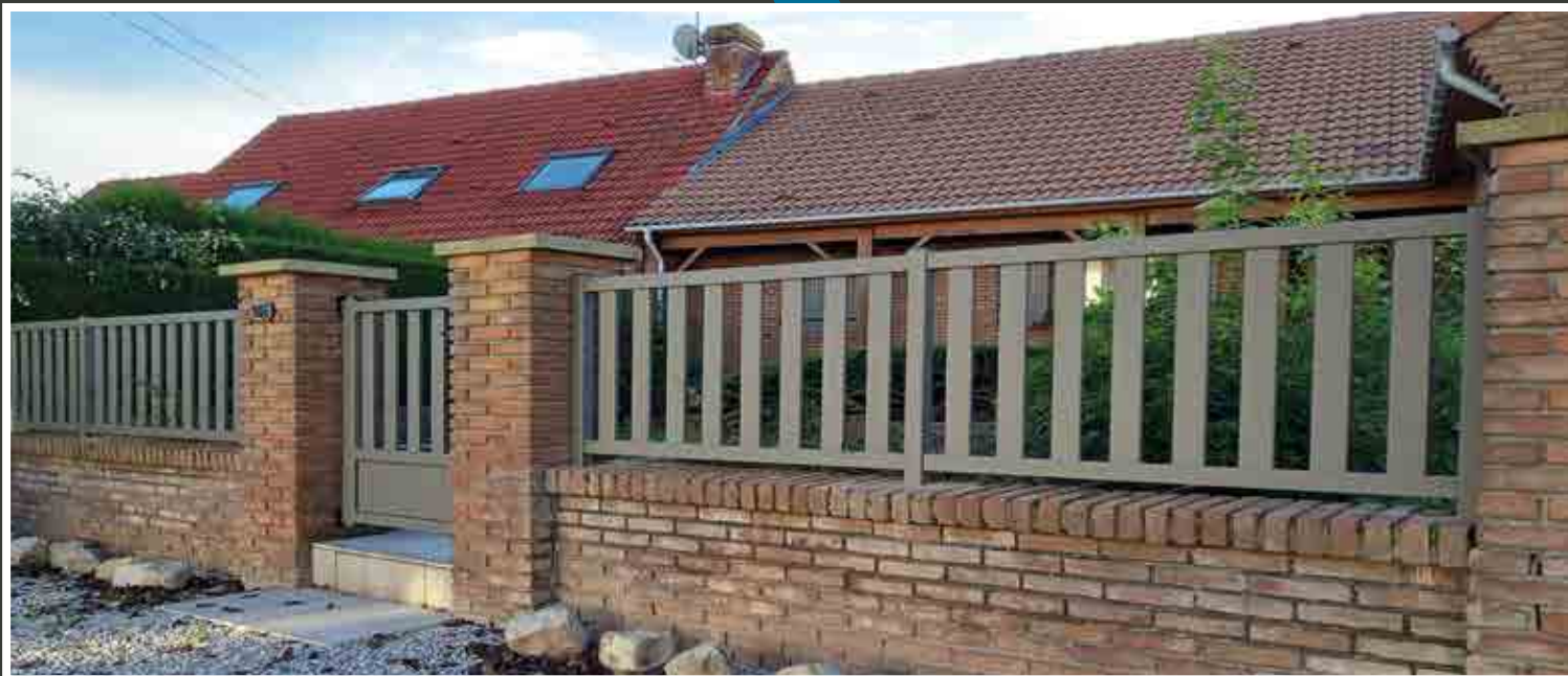
Lames verticales espacées sur muret
