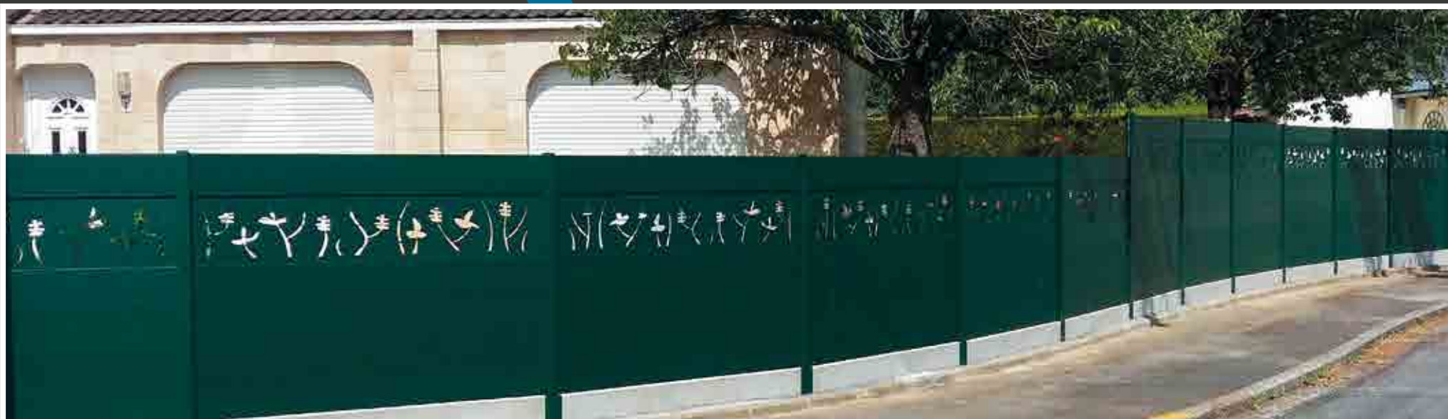
Clôture lames horizontales accolées + bandeaux tôles modèle D avec soubassement plaques béton
